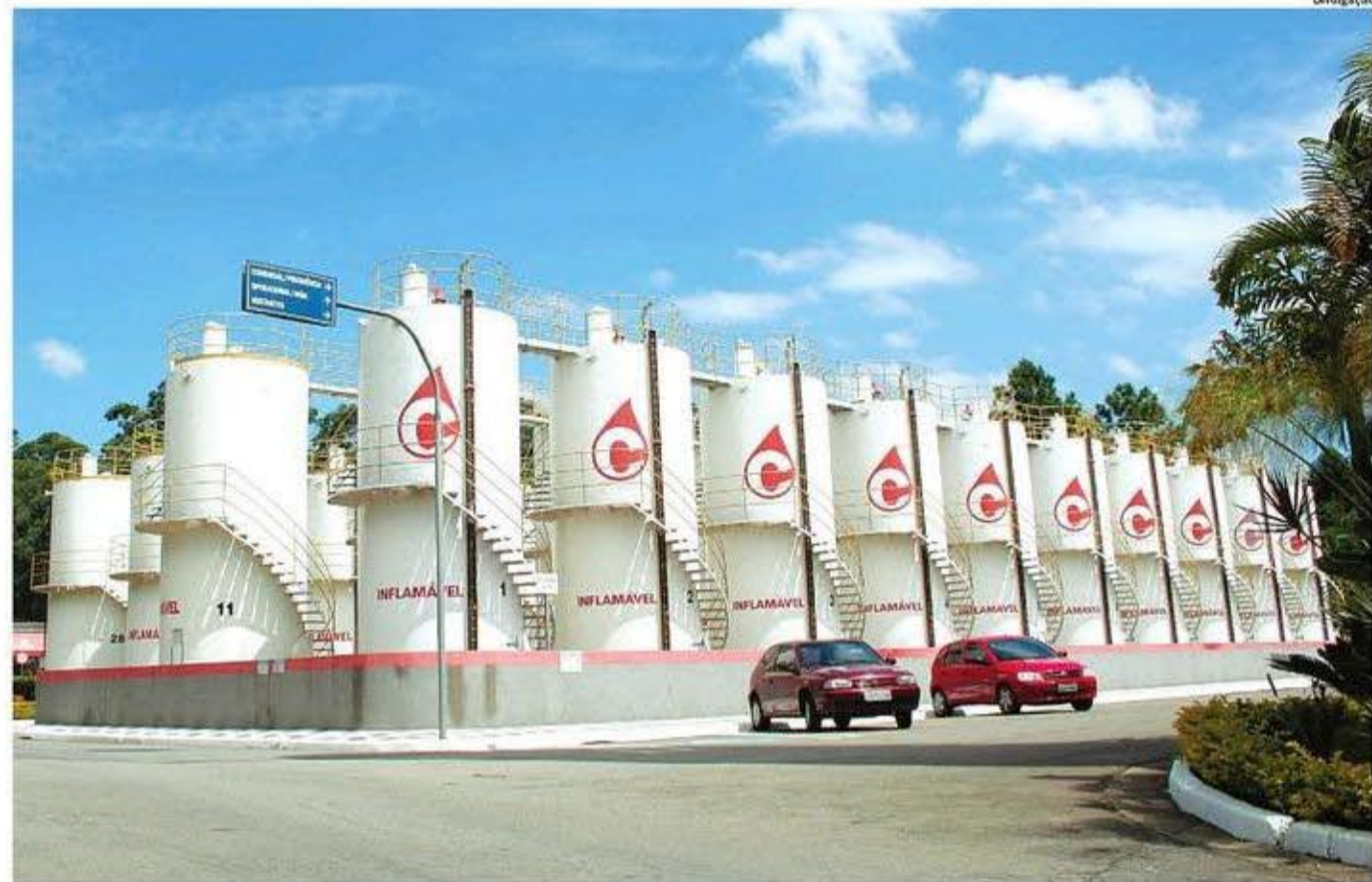
Sede da Carbono Química, em São Bernardo, conta com área de 25 mil metros cúbicos de tanques para solventes e outros insumos
